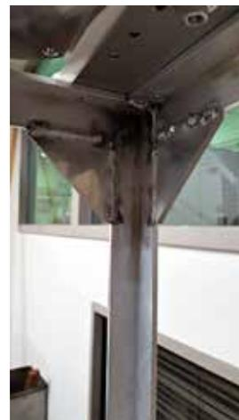
写真2 補強板溶接外観図
